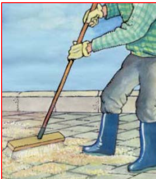
Eliminar el exceso de arena con cepillo.
